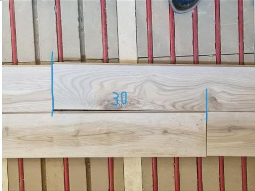
Bei der Verlegung von fallenden Breiten darauf achten, dass der Hirnholzstoß immer zur Nachbarreihe ca. 20- 30 cm versetzt ist.
