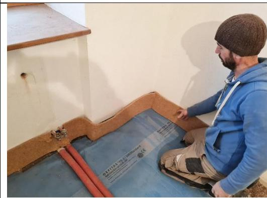
Anschließend die Randdämmstreifen anbringen.
