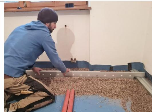
Falls nötig: Lastabtragende Ausgleichsschüttung einbringen und abziehen, zum Ausgleich von Unebenheiten des Bodens und Überdeckung von Installationsrohren.
