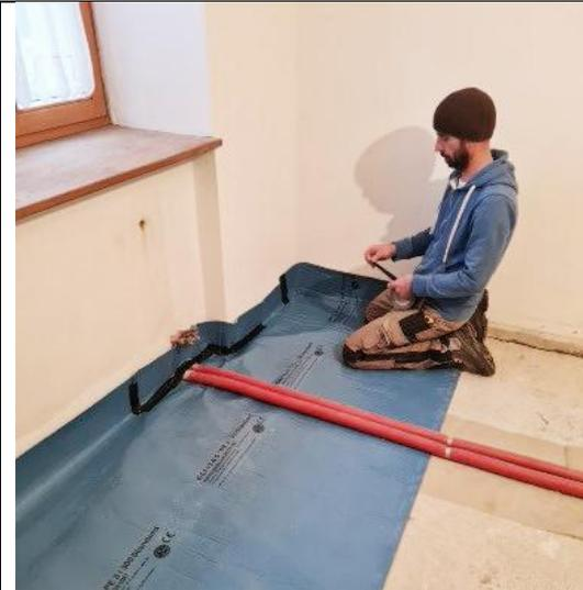
Bringen Sie eine Abdichtung gegen aufsteigende Feuchtigkeit ein (dies ist nur nötig, bei Kontakt vom Unterboden zum Erdreich).
