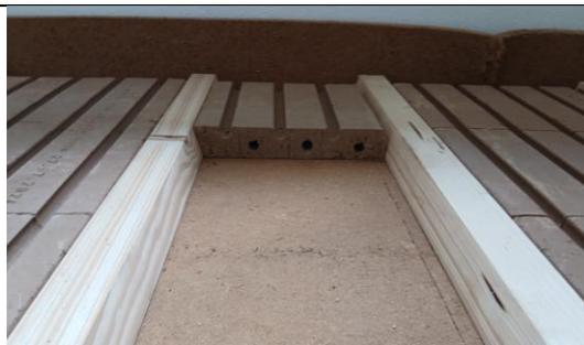
Im restlichen verbleibenden mittleren Bereich wird dann eine Platte eingeschnitten.
