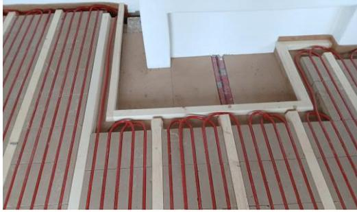
Sind Übergänge z. B. zu Fliesenbereichen vorhanden, sollten diese mit einer Lagerlatte abgeschlossen werden.
