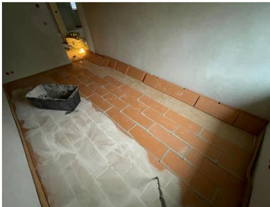
Wird eine Verlegung ohne Lagerlatten gewünscht, sollten die Lethermo-Wall Platten verwendet werden. (mit Nut und Feder)
