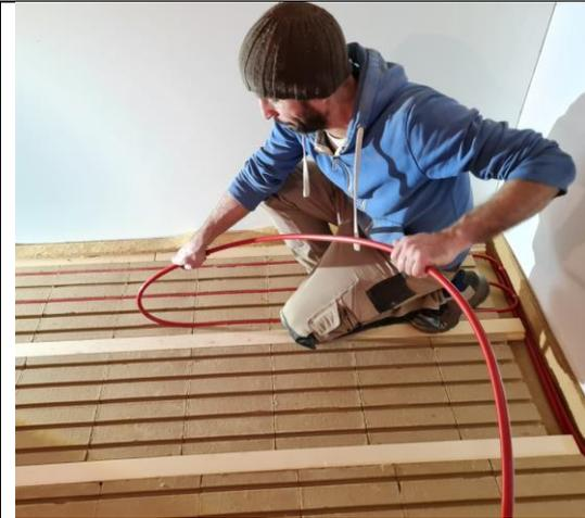
Bei einer 5-fach Belegung müssen die „Umkehrbögen“ bei der Rohrüberkreuzung etwas nach unten gebogen werden – damit die Rohre nicht über die Montageebene nach oben hervorstehen.
