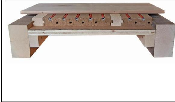
Im Fehlbodenbereich können die Platten auch zwischen den Balken „abgesenkt“ verarbeitet werden. Meist wird man dann gut um die Rohrstärke nach oben überstehen lassen (falls von der Statik her ausreichend, könnten die Rohre auch in die Balken geschlitzt werden).
