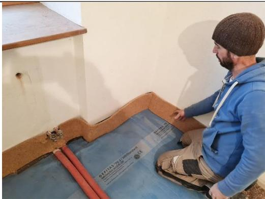
Anschließend die Randdämmstreifen anbringen.
