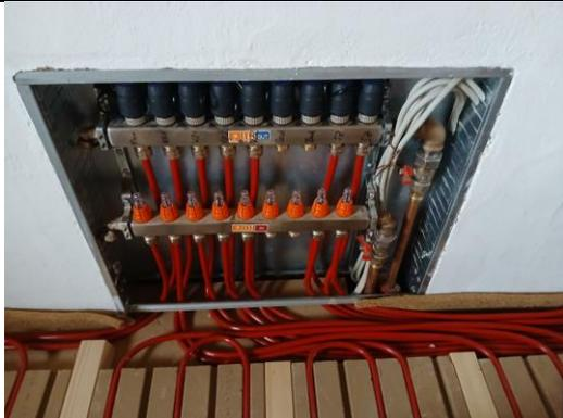
Rohre mit ausreichend Überstand (ca. 50-100 cm) beim Heizkreisverteiler rausstehen lassen und beschriften. (Heizkreisnummer, Vorlauf und Rücklauf)
