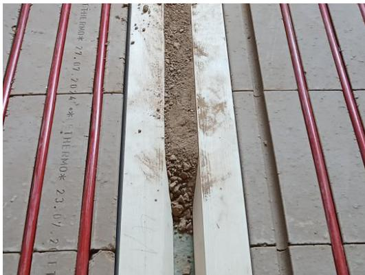
Oder es kann dieser Bereich auch mit Lehmsplitt verfüllt werden. (ggf. könnte auch dieser Bereich mit einem Wärmerohr aktiviert werden.)
