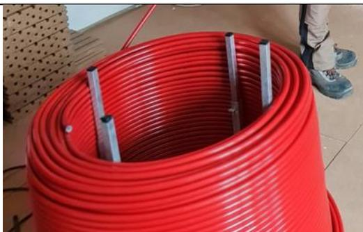
Rohrabwickler in Nähe des Verteilerkastens aufstellen.
