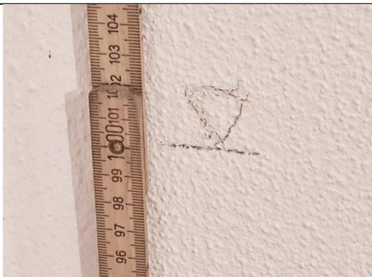
Legen Sie die Aufbauhöhe im Objekt fest (z. B. durch Meterriss).
