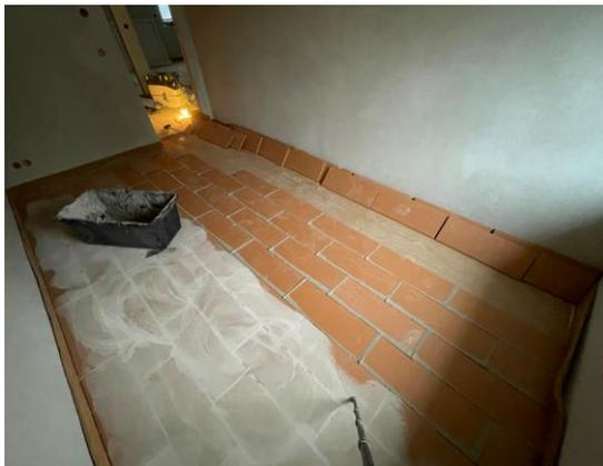
Darauf kann dann eine ggf. Papiertrennschicht ausgelegt werden und ein Trockenestrich verlegt werden. (in diesem Fall Tonality – diese könnten auch beflieselt werden)
