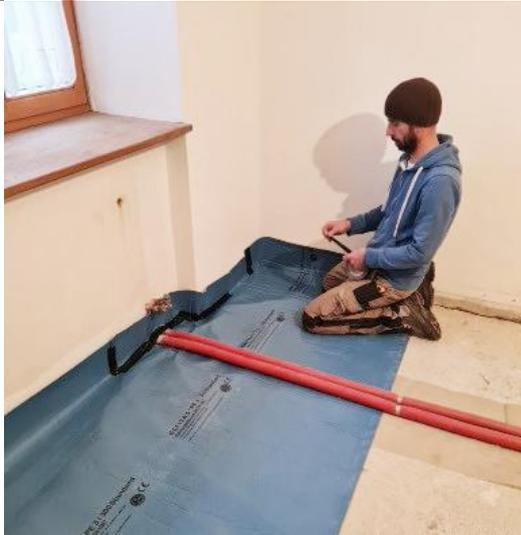
Bringen Sie eine Abdichtung gegen aufsteigende Feuchtigkeit ein (dies ist nur nötig, bei Kontakt vom Unterboden zum Erdreich).
