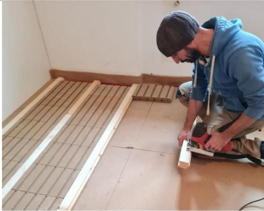
Das Verlegerohr sollte später nicht an scharfen Kanten anliegen – da es durch die Temperaturunterschiede im Rohr zu leichten Bewegungen kommen kann (und sich damit das Rohr aufscheuern könnte)
