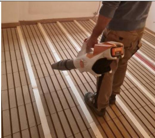
Sind die Latten und Platten verlegt, müssen die Rillen gereinigt werden.
