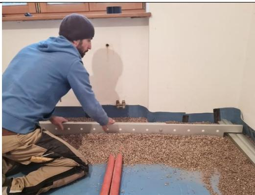
Falls nötig: Lastabtragende Ausgleichsschüttung einbringen und abziehen, zum Ausgleich von Unebenheiten des Bodens und Überdeckung von Installationsrohren.
